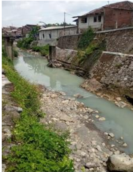
Gambar 1. Kondisi sungai Silandak sebelum penanganan
